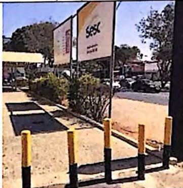
Obstáculos no acesso lateral
