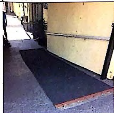
Rampa de acesso com inclinação maior que 8,33%
