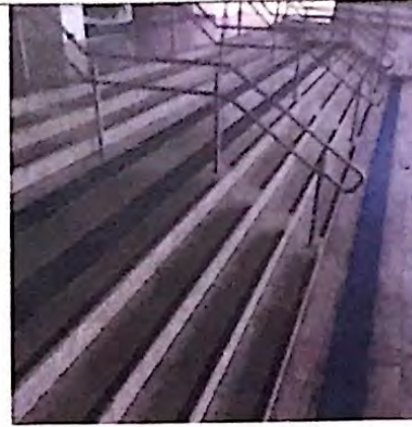
Escada no acesso norte
