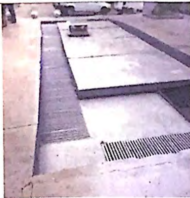
Calçada no acesso norte - subestação
