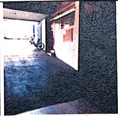
Rampa para acesso de veículos ao subsolo
