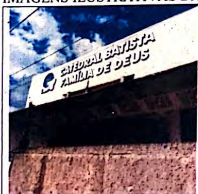
Fachada da edificação
