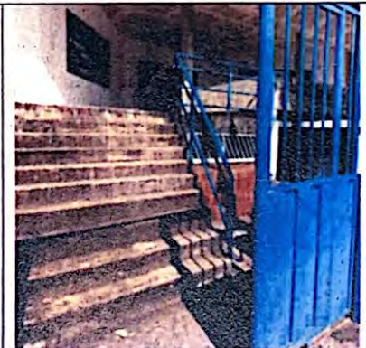
Portão de acesso
