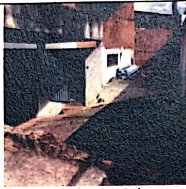
Rampa para acesso de veículos ao subsolo
