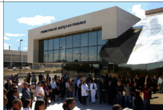
O prédio da PJ do Paranoá foi inaugurado em junho de 2008.
